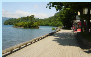
歩道 (ウッドデッキ)
