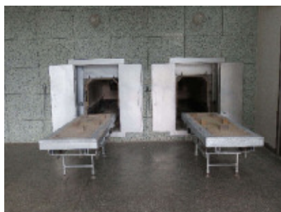
老朽化に伴い改修を行なう2基の火葬炉
