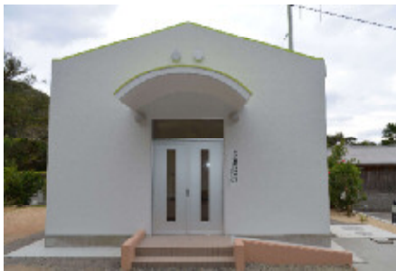
徳浜集落に新しく建設された離島住民生活センター
