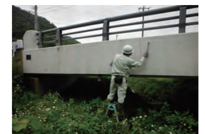
（橋の老朽化対策）
