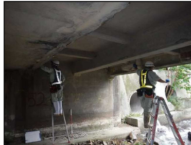
「定期点検 1回/5年」 近接目視による定期点検
