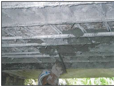
補修状況(断面修復)
