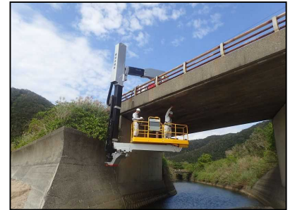
橋梁点検車点検
