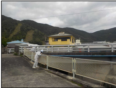
「通常点検」 日常パトロール
